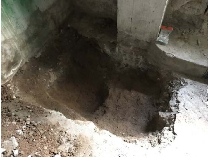
Fonament UE 101 i UE 102 en procés d'excavació
